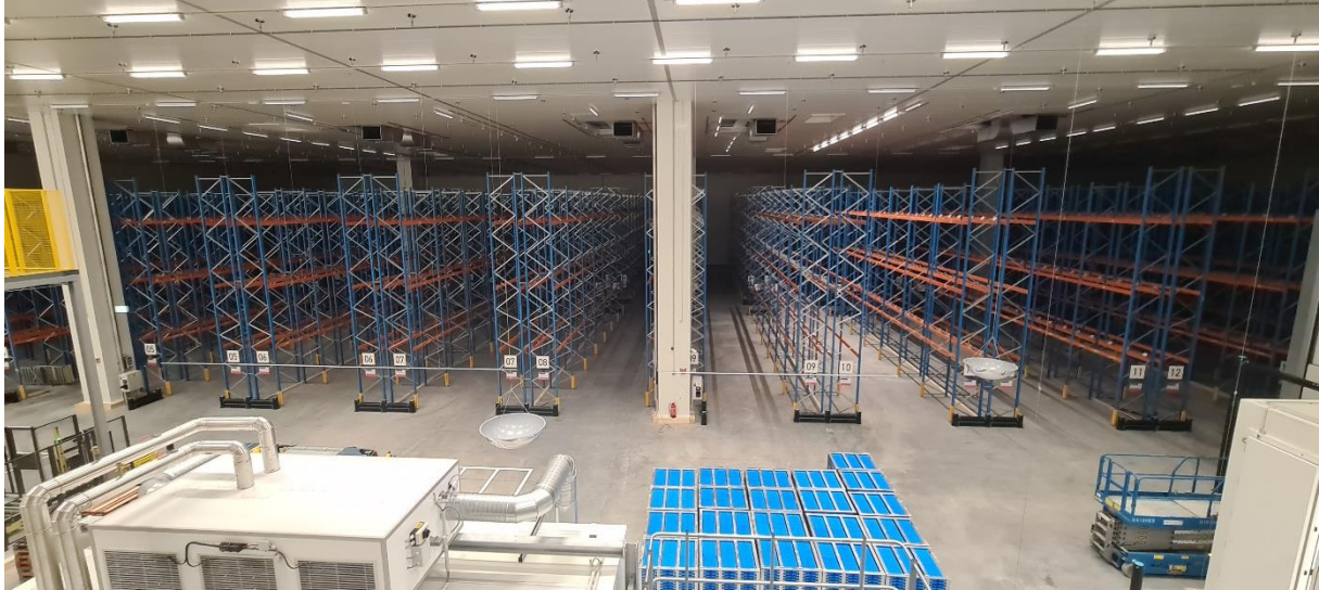
Das neue Regalsystem im neuen Tiefkühlager bietet viel Fläche.
